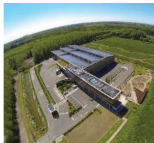
2011 Centre de tri des emballages
