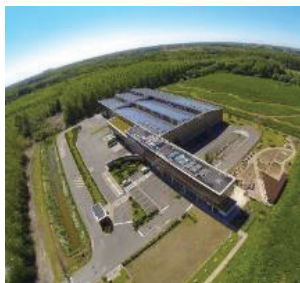
2011 Centre de tri des emballages
