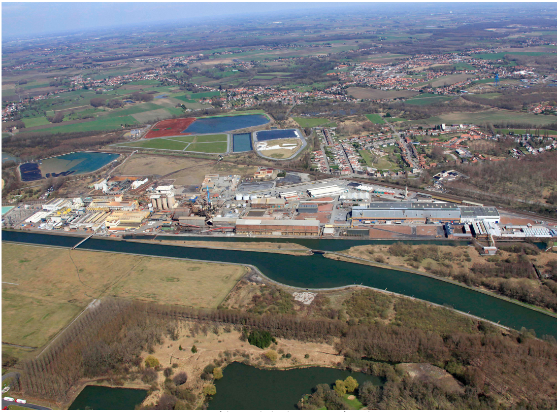
Vue aérienne de l'usine Nyrstar à Aubry
