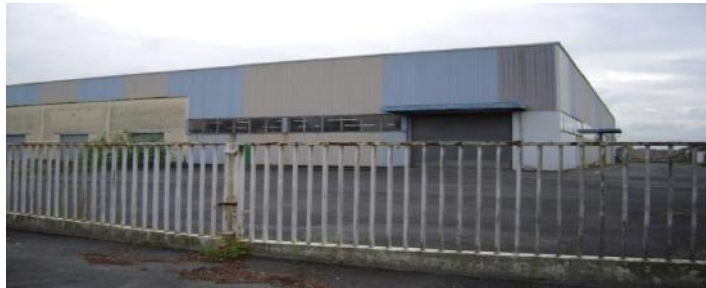
Usine avant travaux (5500 m2 couvert) => et après 1 300 K€ de travaux
