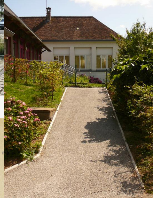
L'enrobé poreux Les dalles alvéolaires
