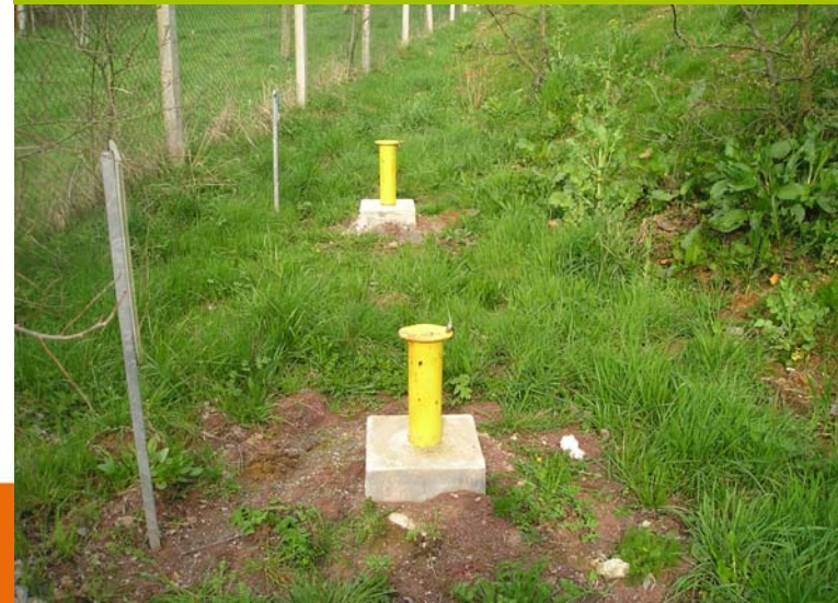
Piézomètres pour le suivi des eaux souterraines
