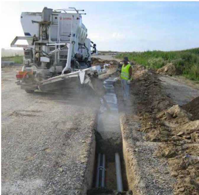
Coulis auto-compactant en remblai de tranchée
