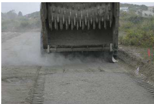
Traitement à la chaux et au ciment
