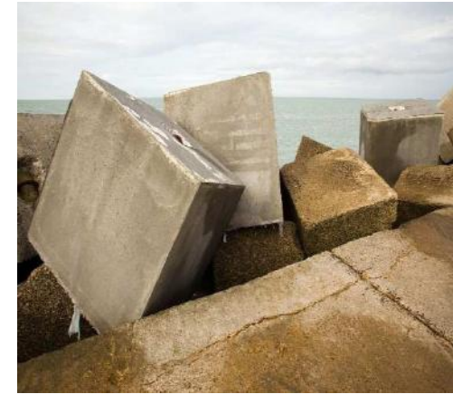
Renforcement de digues
