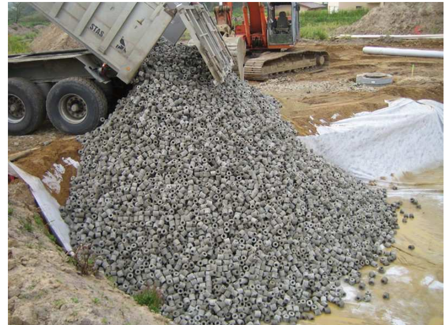
Béton non structurant pour chaussée réservoir
