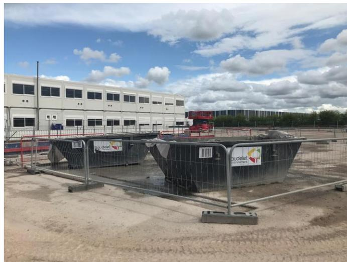
Gestion des laitances de béton avec des bennes filtrantes
